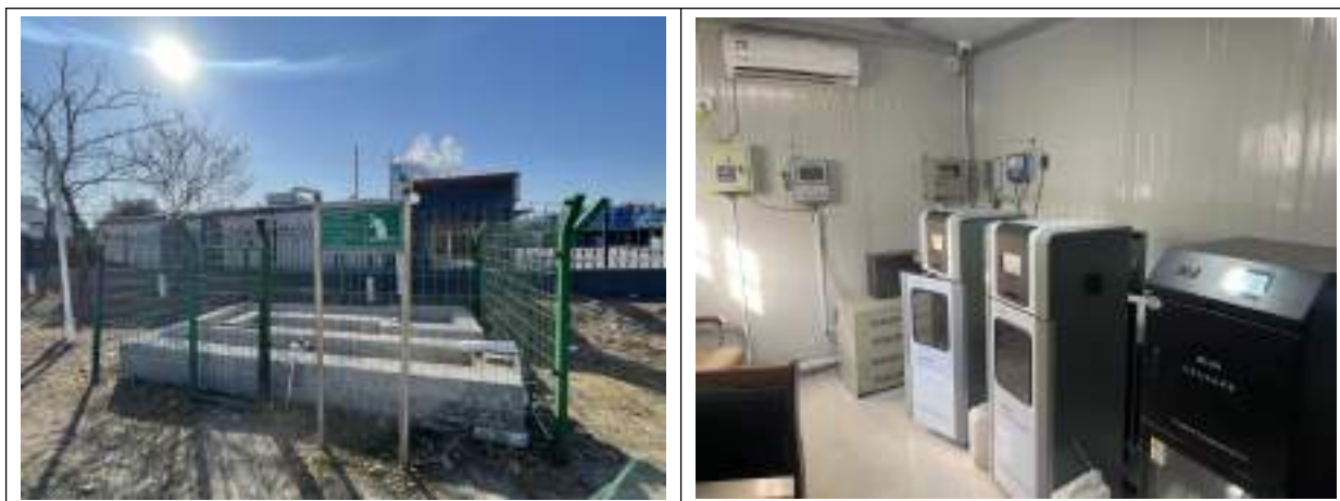
图4-2 排污口、监测设施及在线监测装置现场照片
