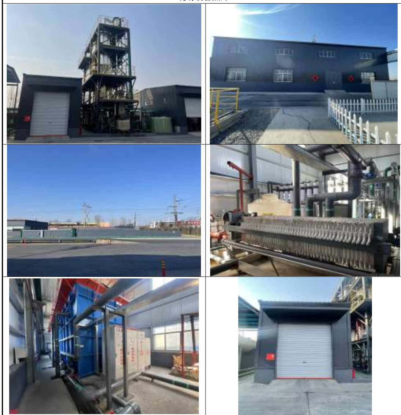
现场设备照片
